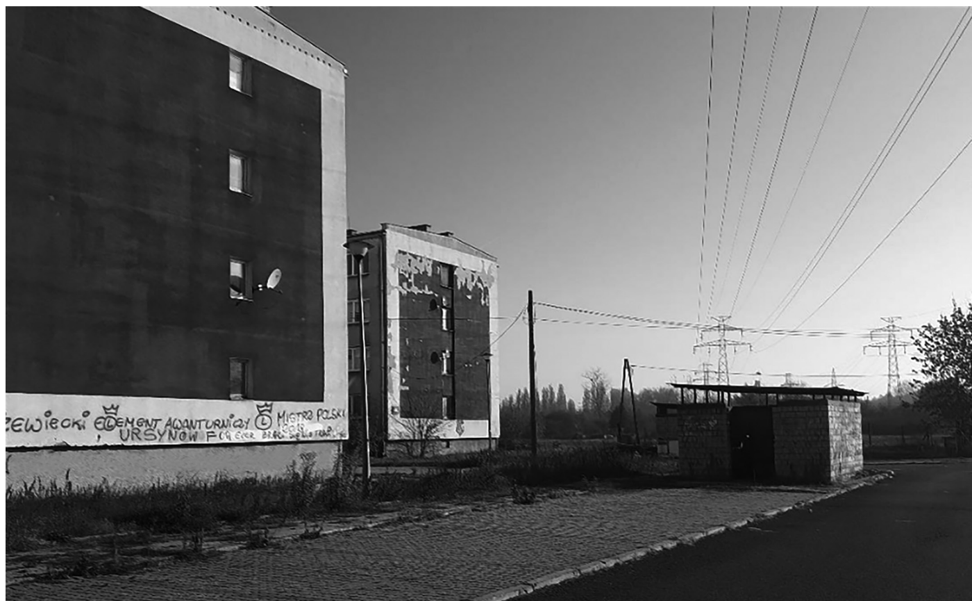
Ryc. 2. Bloki osiedla Dudziarska, stan na 1 listopada 2019 roku
